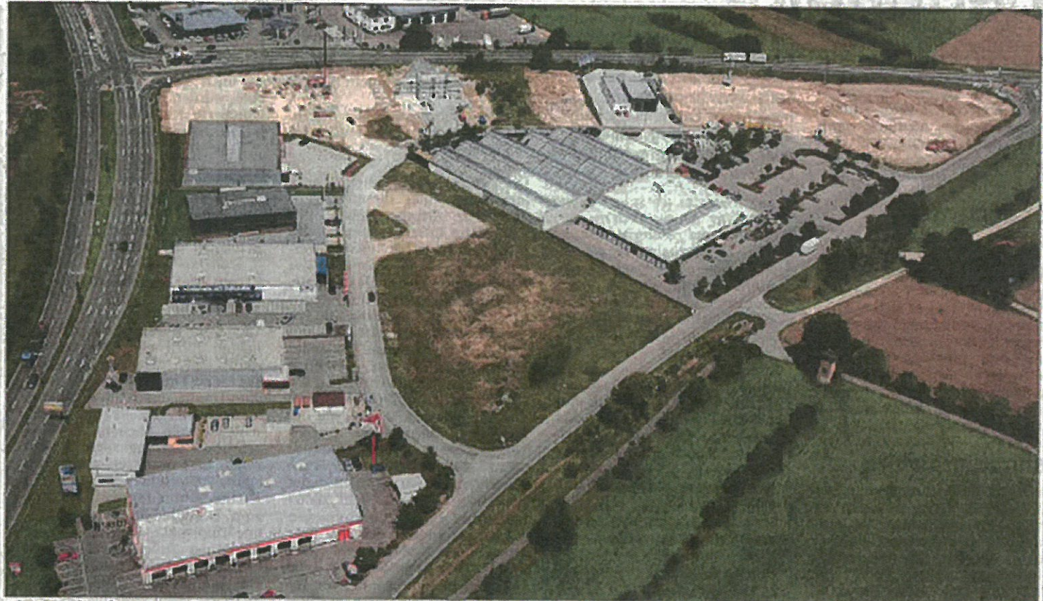
Die Tieräcker füllen sich: Auf dem Eckgrundstück links oben siedelt sich die Fachmarktgruppe TTL an, rechts daneben grenzt an den dreieckigen ITC-Neubau das Grundstück der Baufaschnerei Akst an, ganz rechts das Areal des Autohauses Rudhart. Geyer-Luftbild
