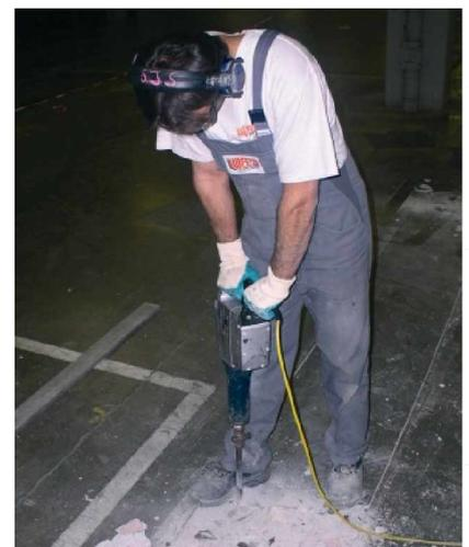
Arbeiten mit Bohr- und Stemmhämmern sind ein typisches Beispiel für Hand-Arm Vibrationen.
