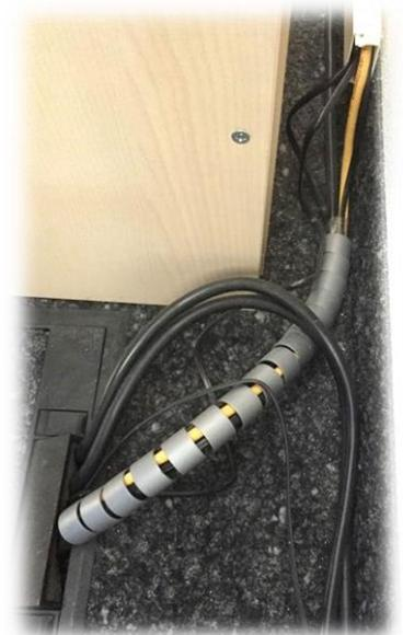
Kabelführung aus einem Bodentank in einer Kabelspirale zum Kabelkanal an der Wand. Daneben ein Beispiel mit Verbesserungspotential.
