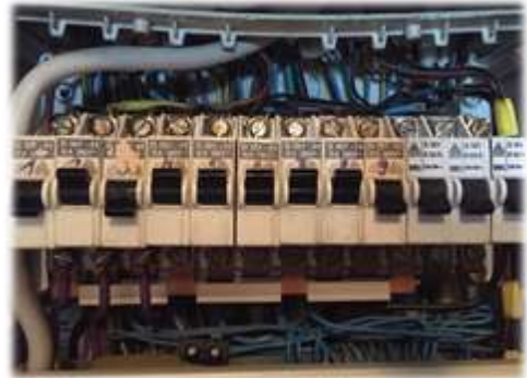
Bildquelle: MPS Elektrotechnik GmbH
