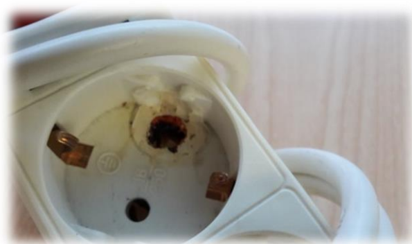
Bildquelle: MPS Elektrotechnik GmbH
