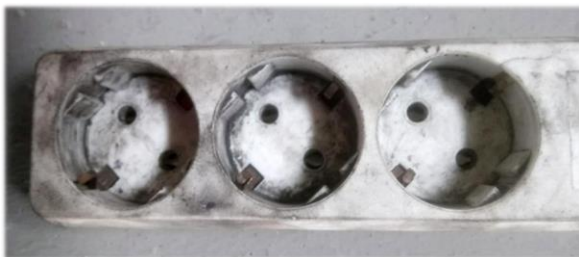
Bildquelle: MPS Elektrotechnik GmbH
