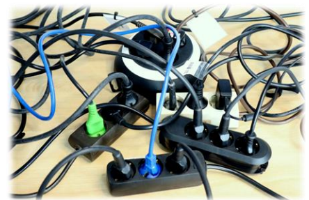
Bildquelle: MPS Elektrotechnik GmbH
