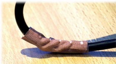
Bildquelle: MPS Elektrotechnik GmbH
